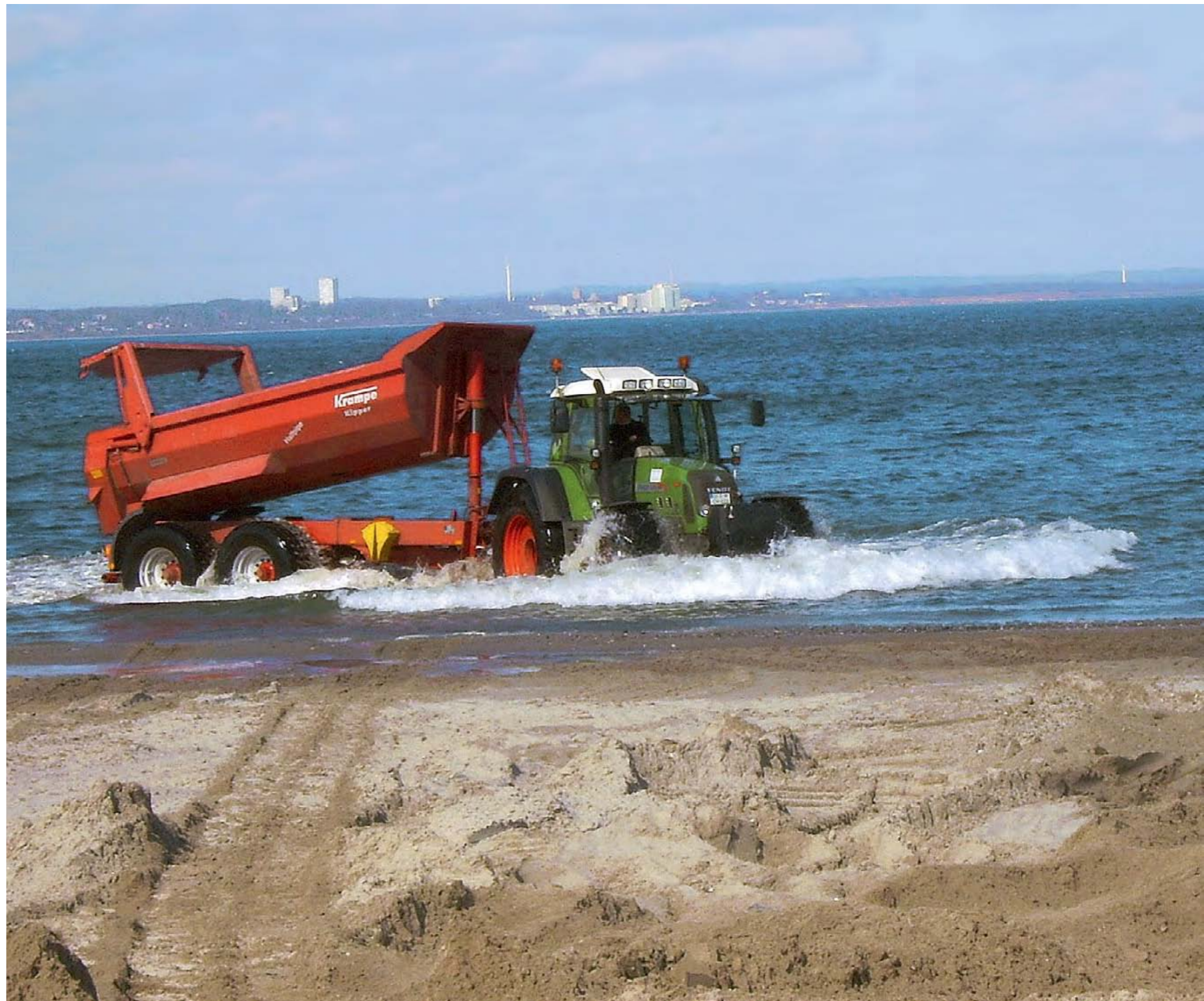
Над 20000 тона чакъл транспортира фирма Геверс за разширяване на крайбрежната ивица на Балтийско море при Тиммендорф.
